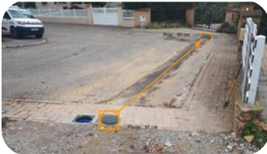
Réalisation d'un branchement eaux usées DN160 11ml PVC Allée des Haut de Saone
